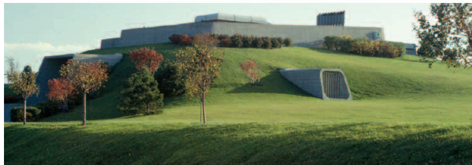
Station de pompage situé à l'intersection des rues Saint-Charles et Joliette.
