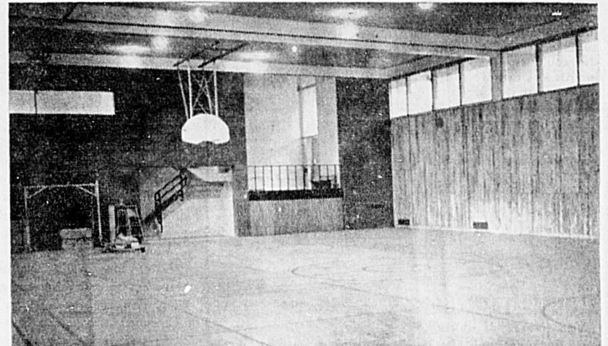
Vue du spacieux gymnase servant à l'enseignement de l'éducation physique, des sports intérieurs, pouvant aussi servir de salle de théâtre et de vue. L'équipement dont il est pourvu fut fourni par CYPIHOT SPORT et équipement de gymnase, situé à 8978 rue Lajeunesse, Montréal, tél. : 389-2714.
