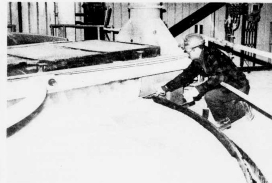
Le filtre horizontal est la dernière étape du procédé de traitement de l'hydrate à l'usine de calcination. Donald Gagnon en prélève un échantillon.
