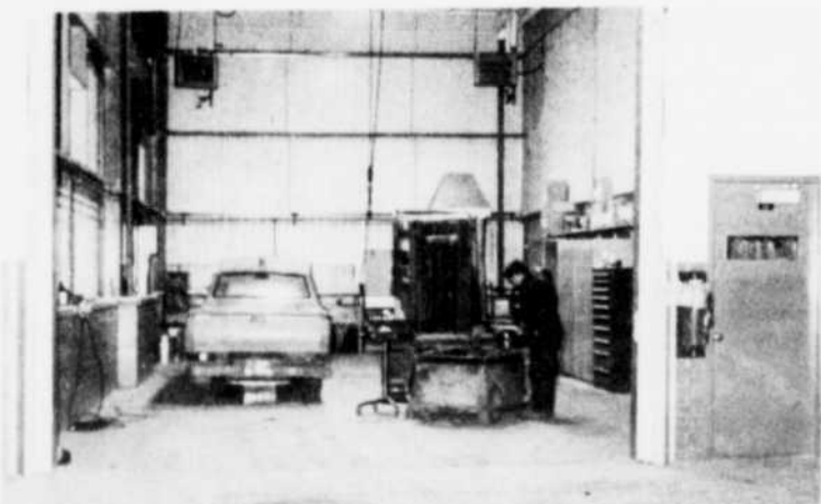
Vue générale du nouveau garage du Centre de coulée Arvida.
