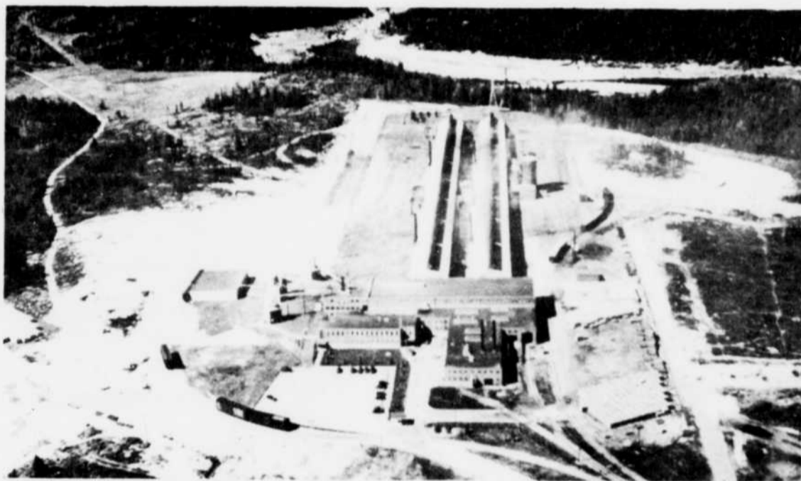
L'Usine Isle-Maligne, telle qu'elle était en 1944!
