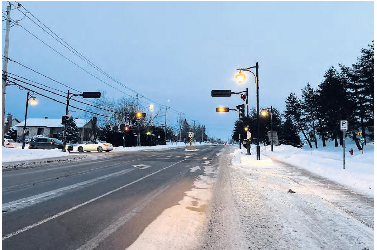
Une réfection de surface sur la rue Bella-Vista, entre les artères Principale et des Hirondelles, est prévue pour l'année 2022. (Photo : Frank Jr Rodi)
