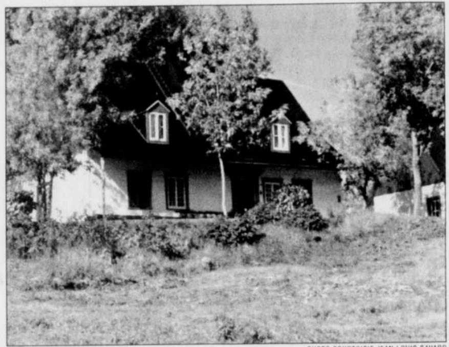
La maison historique des Savard, rue Giroux, à Loretteville, date de 1752. Construite sur le lot de Simon fils, elle a été classée en 1975.
