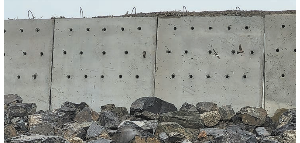
Ces investissements ont permis de réaliser des travaux d'amélioration sur le nichoir pour hirondelles de rivage à la Baie de Beauport par l'aménagement de murets de béton perforés. (Photo : gracieuseté G3E)
