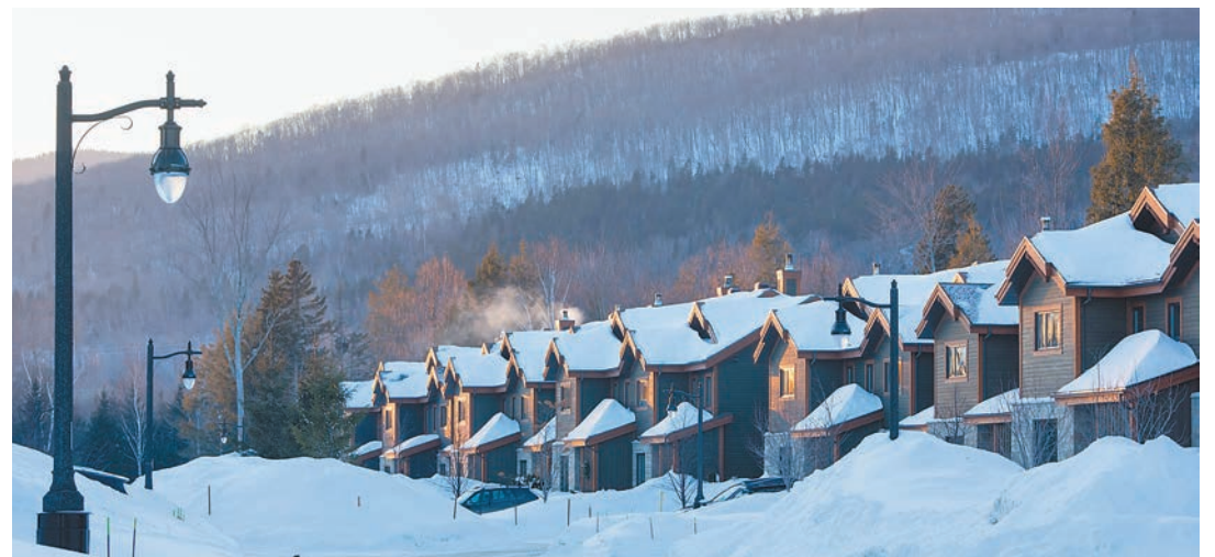
De nombreuses constructions neuves poussent toujours près du Mont-Sainte-Anne, dont le développement domiciliaire FYRA sur le boulevard Bélanger à Beaupré. (Photo : J-F. Simard).
