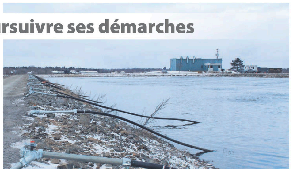
La Ville de Plessisville est satisfaite du jugement rendu par la Commission municipale du Québec et pourra poursuivre ses démarches devant la Cour supérieure dans le litige qui l'oppose à la Paroisse dans la gestion des eaux usées. (Photo gracieuseté)
