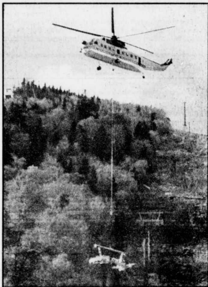
À l'aide d'un hélicoptère Sikorsky S-61, les spécialistes de la firme Dappelmayr ont posé, hier, sur le flanc sud du mont Sainte-Anne, la plupart des 28 tours et leurs « têtes », qui supporteront la nouvelle télécabine du centre de ski. Une opération bruyante et périlleuse qui commande le maximum de précision. Un véritable spectacle !
