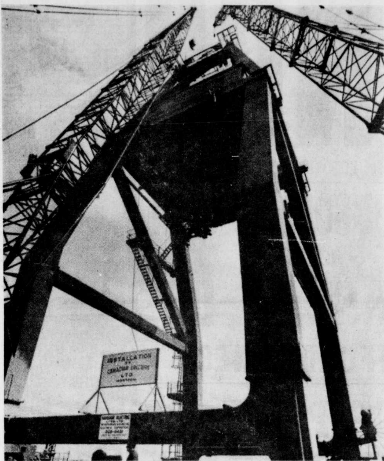
A LA POINTE DU PROGRES — Une structure d'acier de 136 pieds de haut se dresse, depuis hier après-midi, au-dessus du port de Montréal. Il s'agit d'une grue géante pesant 450 tonnes dont la dernière partie vient d'être mise en place et qui sera chargée de recevoir le premier d'une série de trois navires porte-containers de 300 pieds de long. Chacun de ces navires transporterait 500 "boîtes" de 20 pieds qui seraient ensuite acheminées à Toronto par chemin de fer. Dernier cri de la technique des transports. La Métropole du Canada reste toujours à la pointe du progrès.
