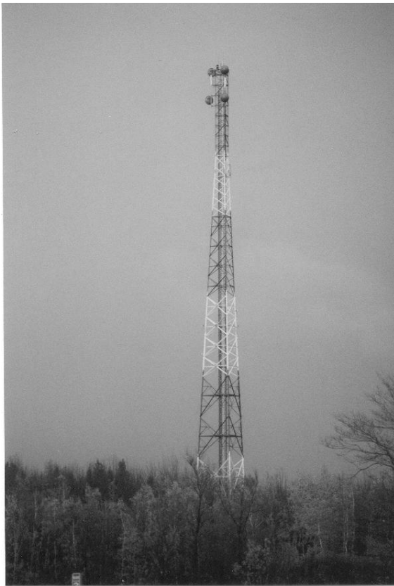
Figure 25. Les tours sans haubans sont considérées moins dangereuses pour les oiseaux migrateurs.
