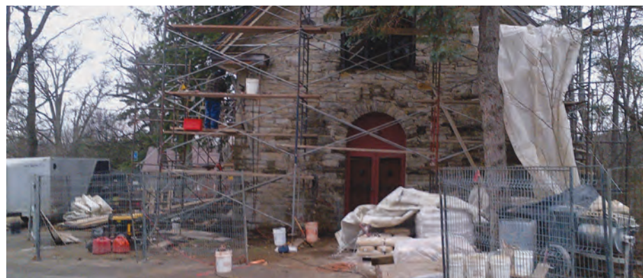
Le chantier sur le musée familial s'est amorcé sur l'enveloppe extérieure.
