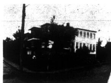
35 Ave du Parc Bonne condition de vente
