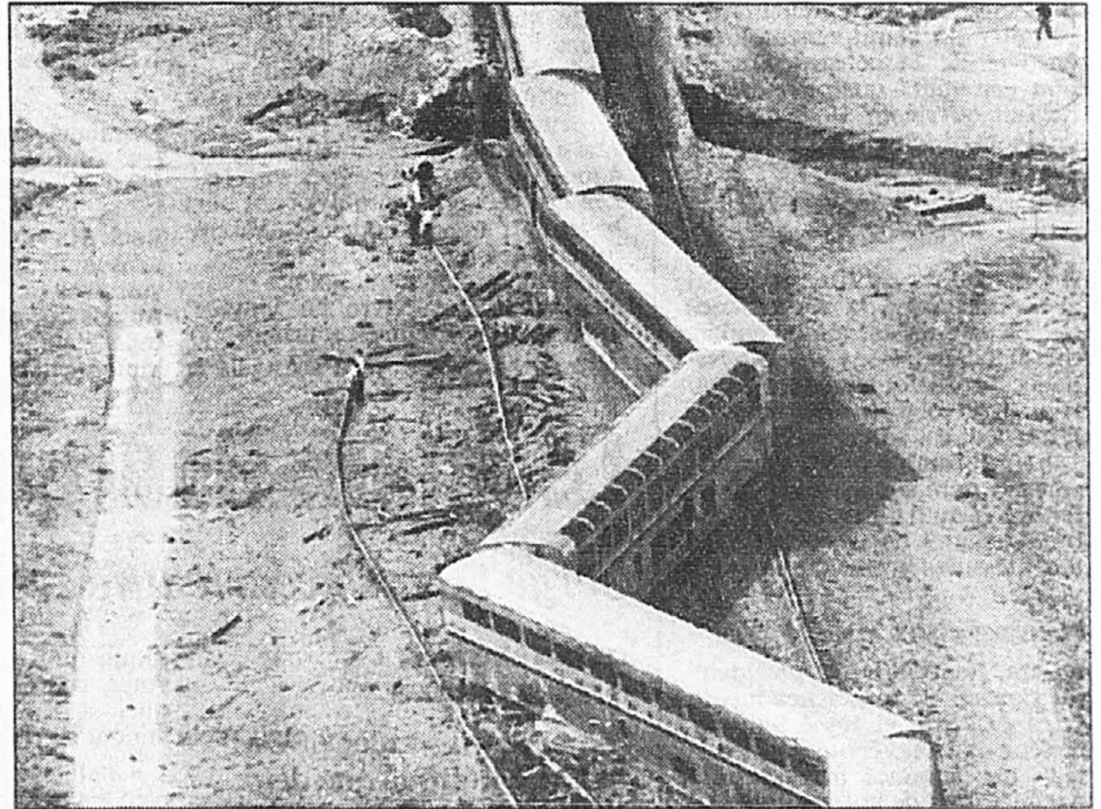
Le convoi a déraillé en raison des pluies torrentielles qui ont miné les assises d'un petit pont au cours des jours précédents.
