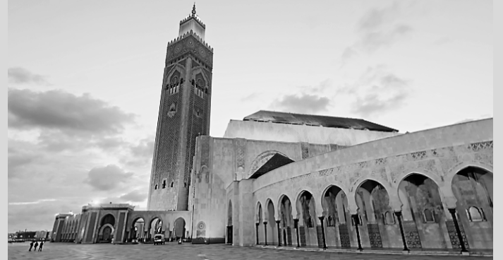
La Mosquée Hassan II à Casablanca
