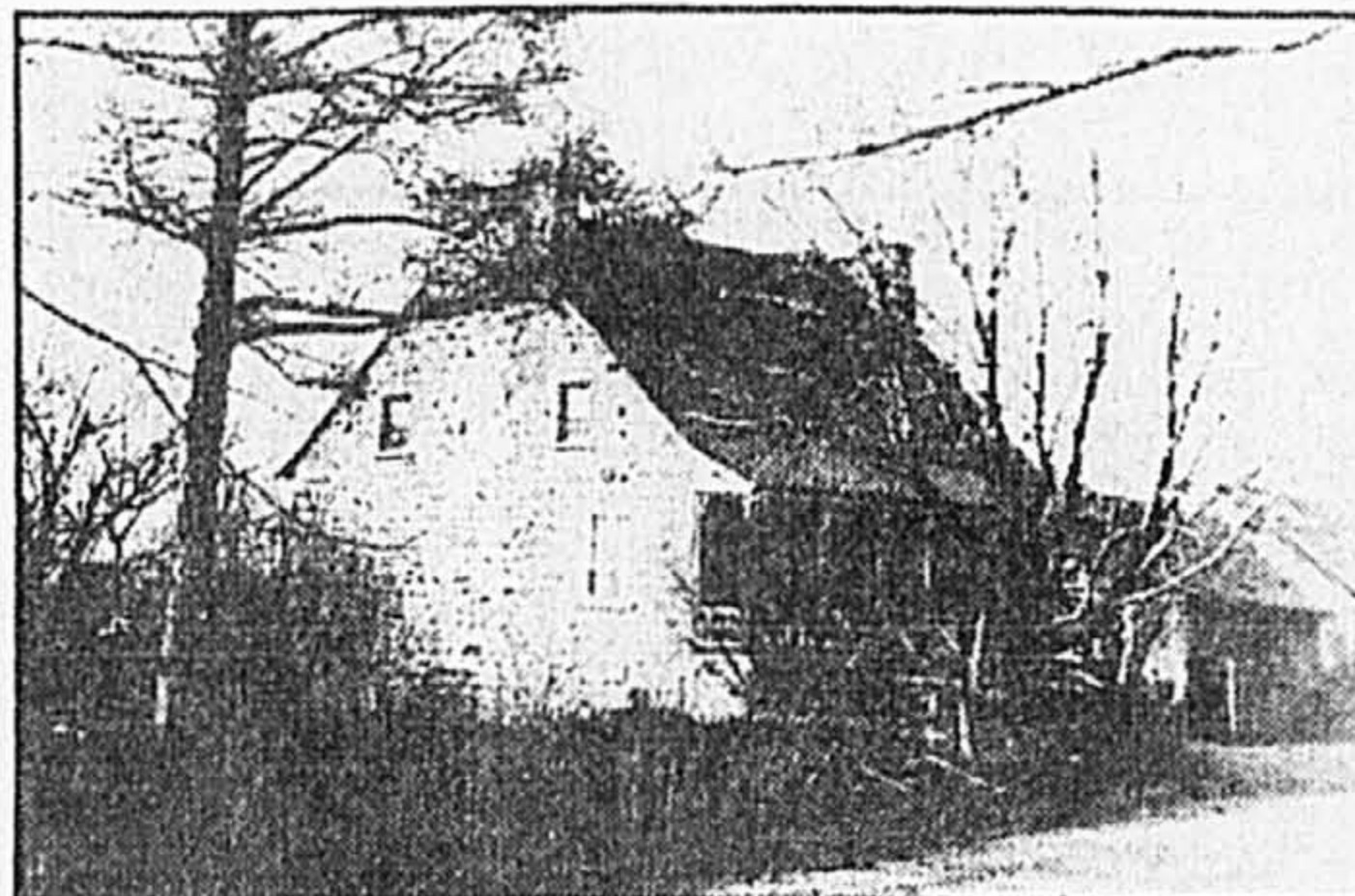
PHOTO VILLE DE MONTREAL-NORD
