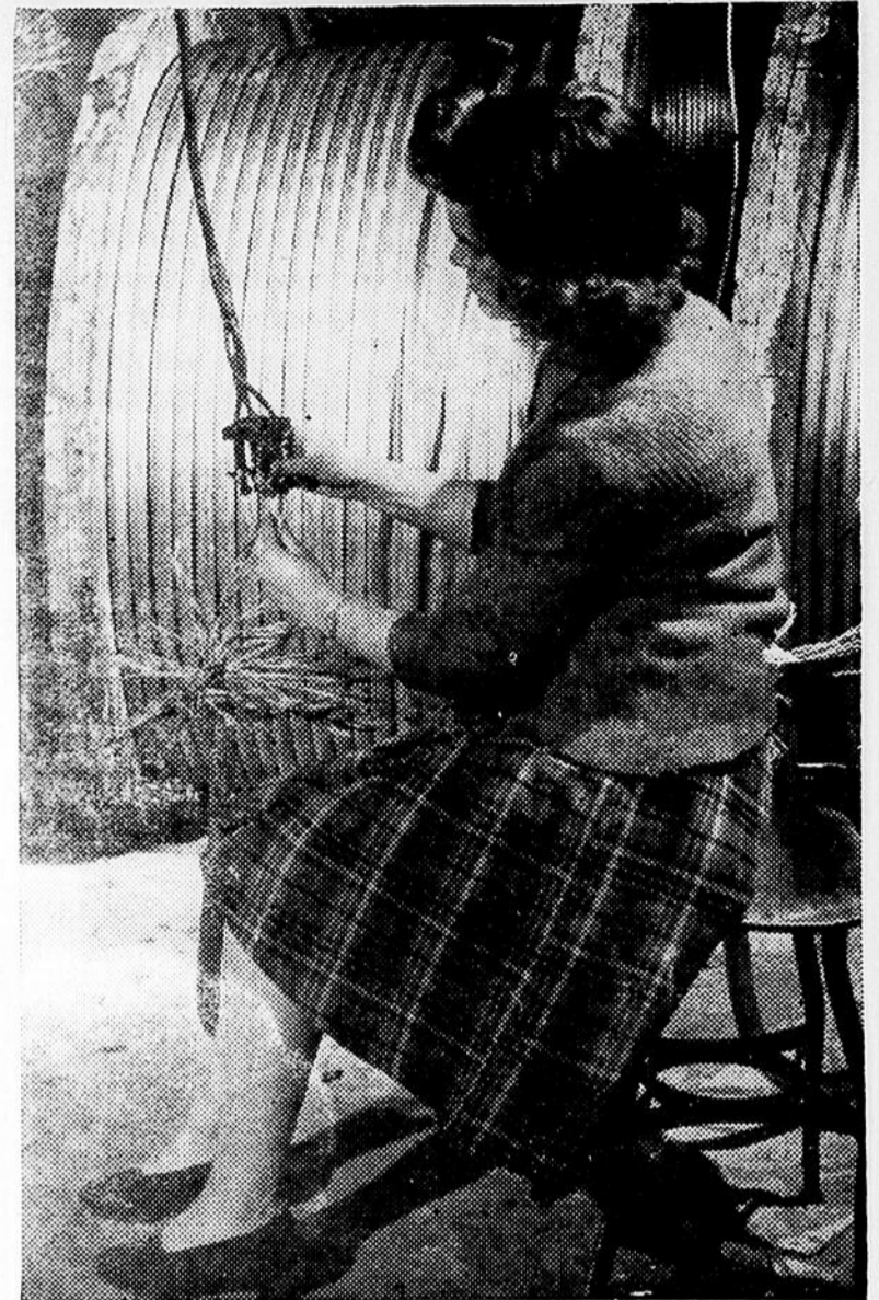
Le croirait-on? . . . Le câble téléphonique que l'on voit ici permet la transmission de douze conversations à la fois, sur un même circuit. On pourrait croire à une véritable confusion et pourtant, chaque conversation est transmise indépendamment de l'autre tout comme un programme radiophonique est diffusé malgré les centaines d'autres émissions sur les ondes. Une ouvrière qualifiée est ici en train de vérifier chaque fil de ce câble dans une usine de Montréal où on les fabrique.
