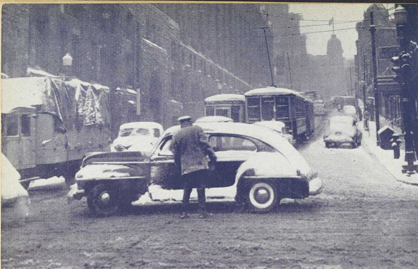
Rue Windsor — vue regardant vers le nord, de la rue St-Antoine
