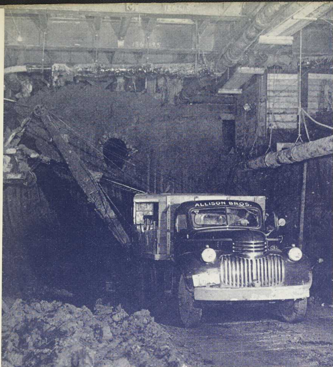
Excavation sous le pontage temporaire Métro de Toronto
