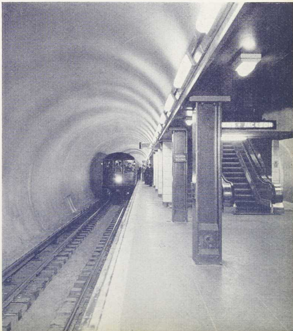
Station avec quai central — Métro de Chicago
