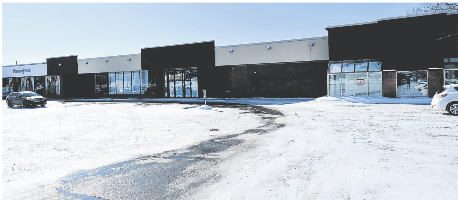
Le centre de conditionnement physique Éconofitness Granby migrera dans les locaux autrefois occupés par le magasin L'Aubainerie, au 840, rue Principale, cet automne. — ALAIN DION
