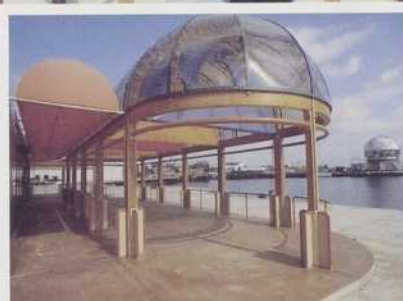
Architecte: Marshall Goldsworthy & Associates Constructeur: Landmark Glass & Aluminium Inc.
