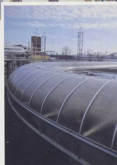
Architecte: Collins Fulker McDonell Maltby Ltd. Constructeur: Columbia Manufacturing Co. Ltd.
