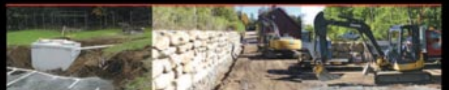
INSTALLATION DE FOSSE SEPTIQUE
