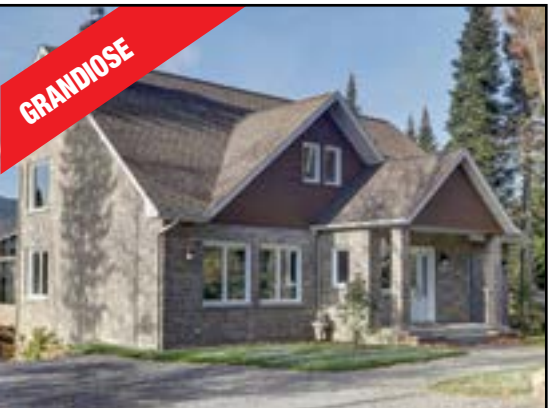
GRANDIOSE STE-BRIGITTE-DE-LAVAL Construction 2011, structure Timber Frame. 4 chambres, 629 000 $
