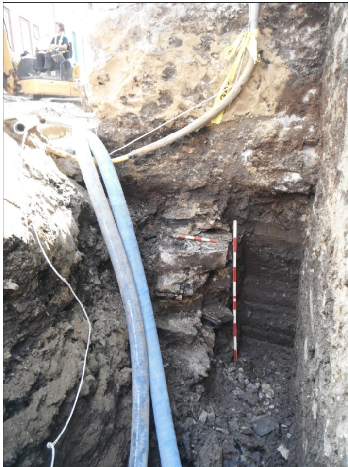
Photo 8. Fondation VDQ1705-2A6 devant le 18, rue Couillard, vue vers l'ouest (VDQ1705-NUM3-075)
