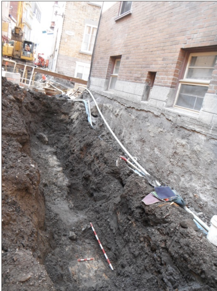
Photo 7. Mur de fondation CeEt-338-3B5, vue vers l'ouest-nord-ouest (VDQ1705-NUM3-61)
