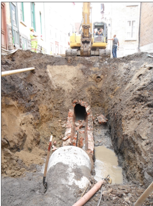
Photo 5. Brick barrel VDQ1705-2A1, vue vers l'ouest (VDQ1705-NUM3-56)
