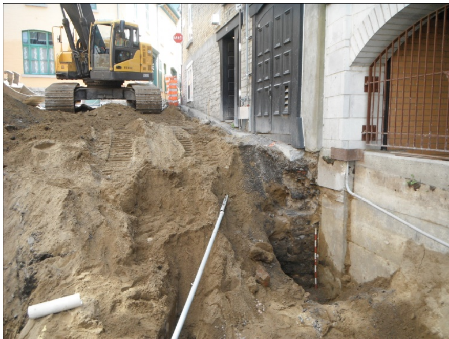
Photo 11. Vestige CeEt-338-3A1 à la jonction des 8 et 12, rue Hamel, vue vers le sud-sud-ouest (CeEt-338-17-NUM2-214)
