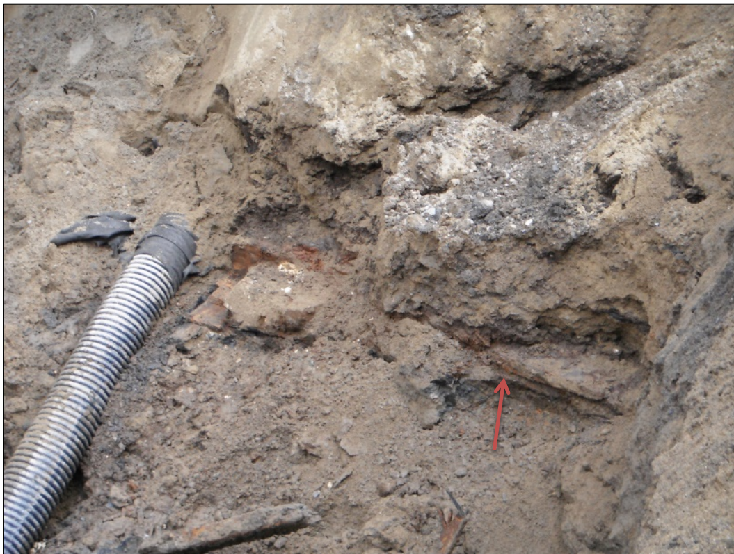
Photo 17. Drain CeEt-80-22E3, vue vers le sud-est (CeEt-80-17-NUM1-171)
