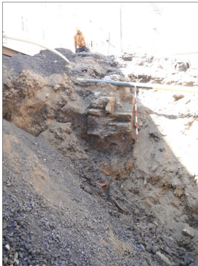
Photo 13. Vestige CeEt-338-3A3 le long de la rue Hamel au coin de la rue Couillard, vue vers l'ouest (CeEt-338-17- NUM2-248)
