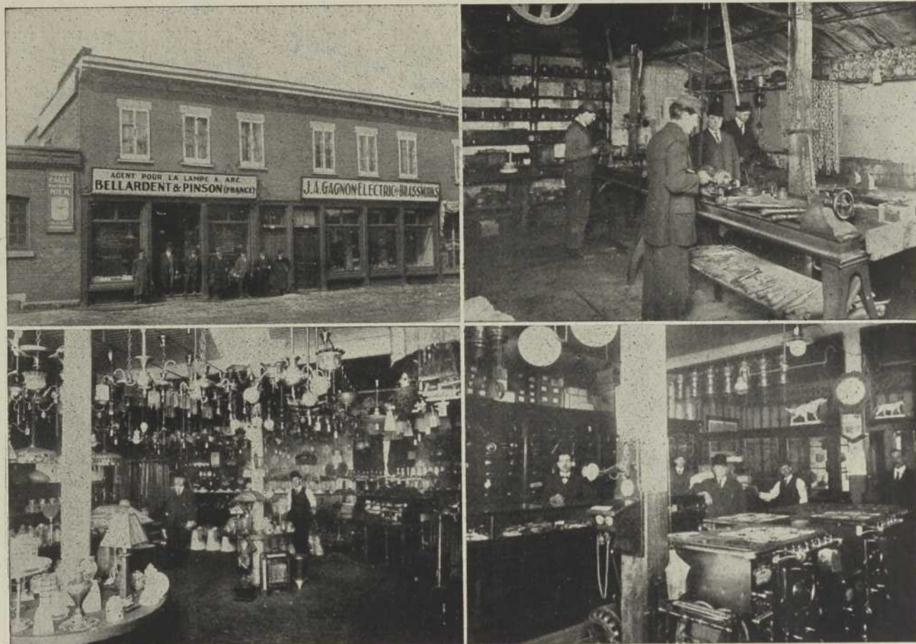
J. A. GAGNON. Contracteur électricien. Département de gros et détail. Manufacture. Salle d'échantillons. Département des fournitures pour électricité. Tél. Est 2018. 733 rue Notre-Dame à Maisonneuve. Etablie en 1896.
