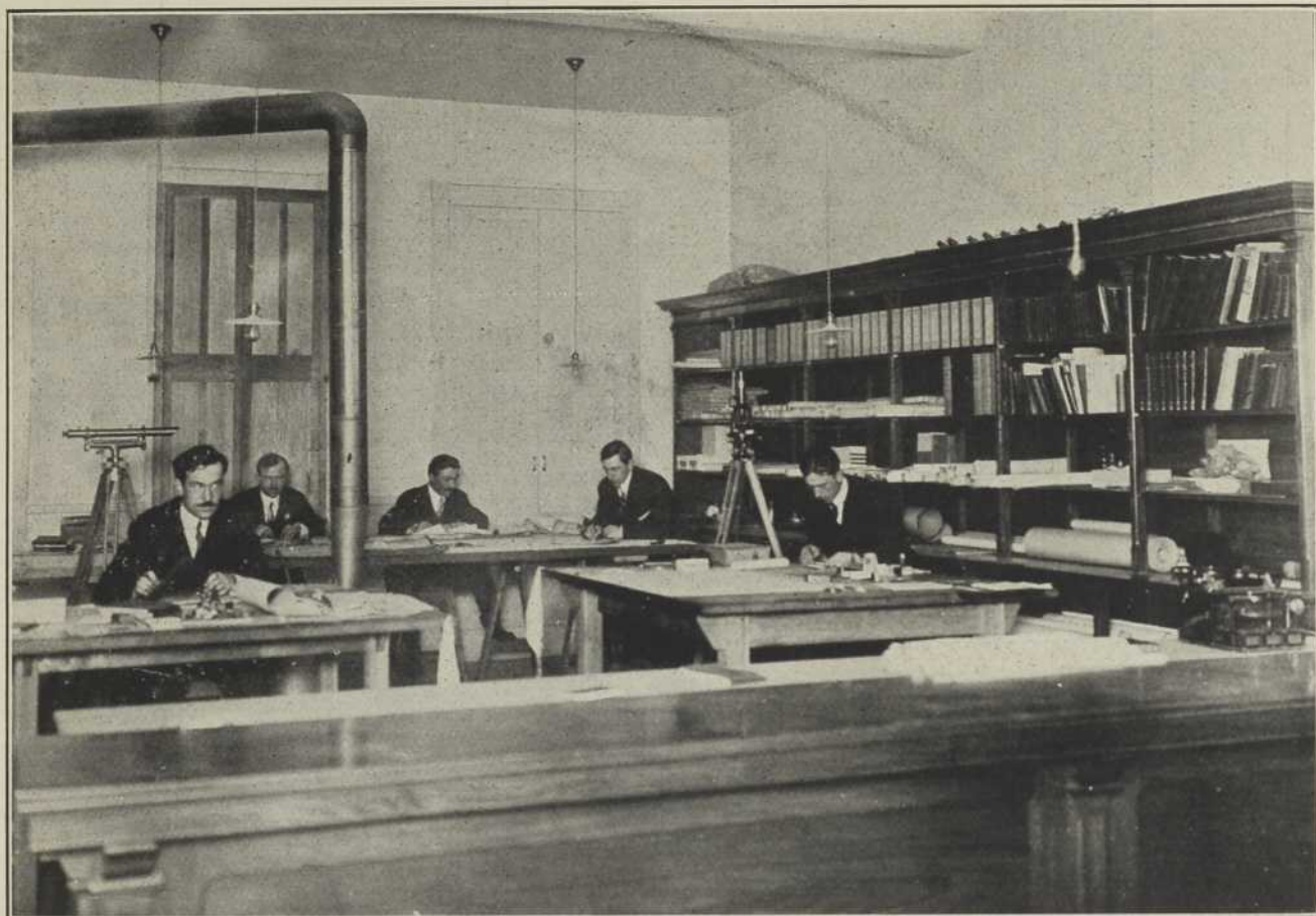
PARTIE DE LA SECTION MECANIQUE.
