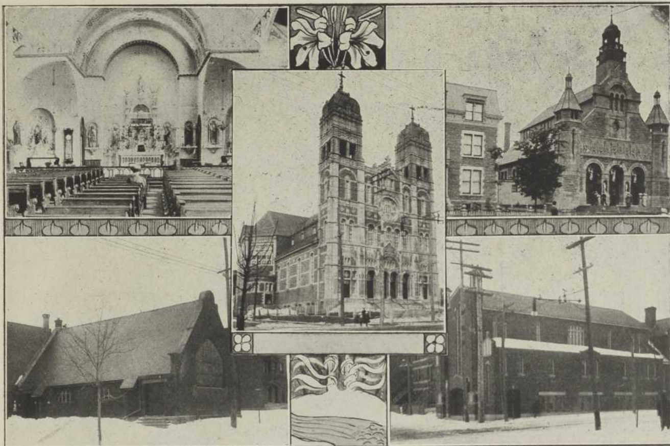
Intérieur de l'église de Saint-Clément; église du Saint-Nom de Jésus (C. A. Reeves, architecte). Extérieur de l'église Saint-Clément; église St-Cyprien, (anglicane); église presbytérienne et école protestante.
