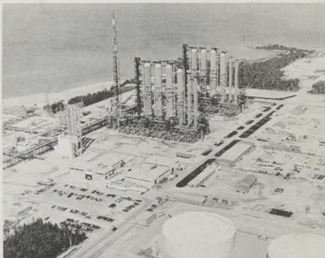
Usine d'eau lourde de Bruce
