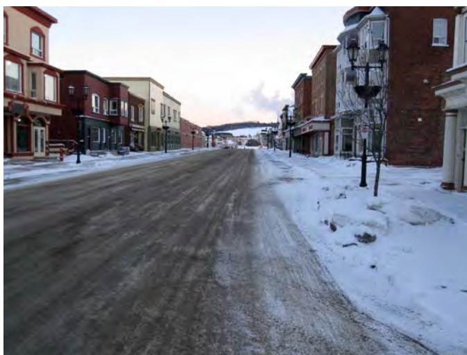
Photo 5 Ancien centre-ville (rue Frontenac) avant sa démolition
