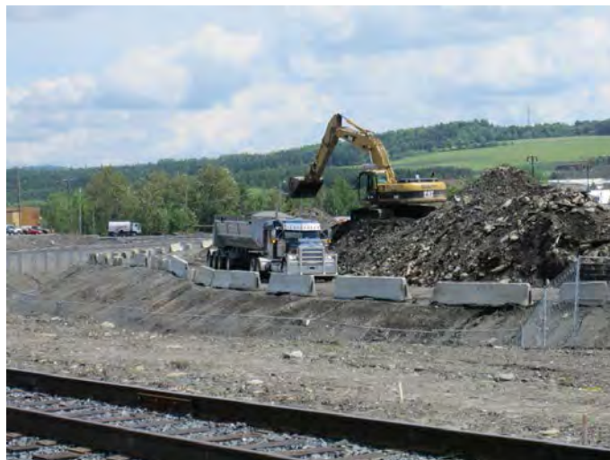
Photo 2 Transport de la terre contaminée
