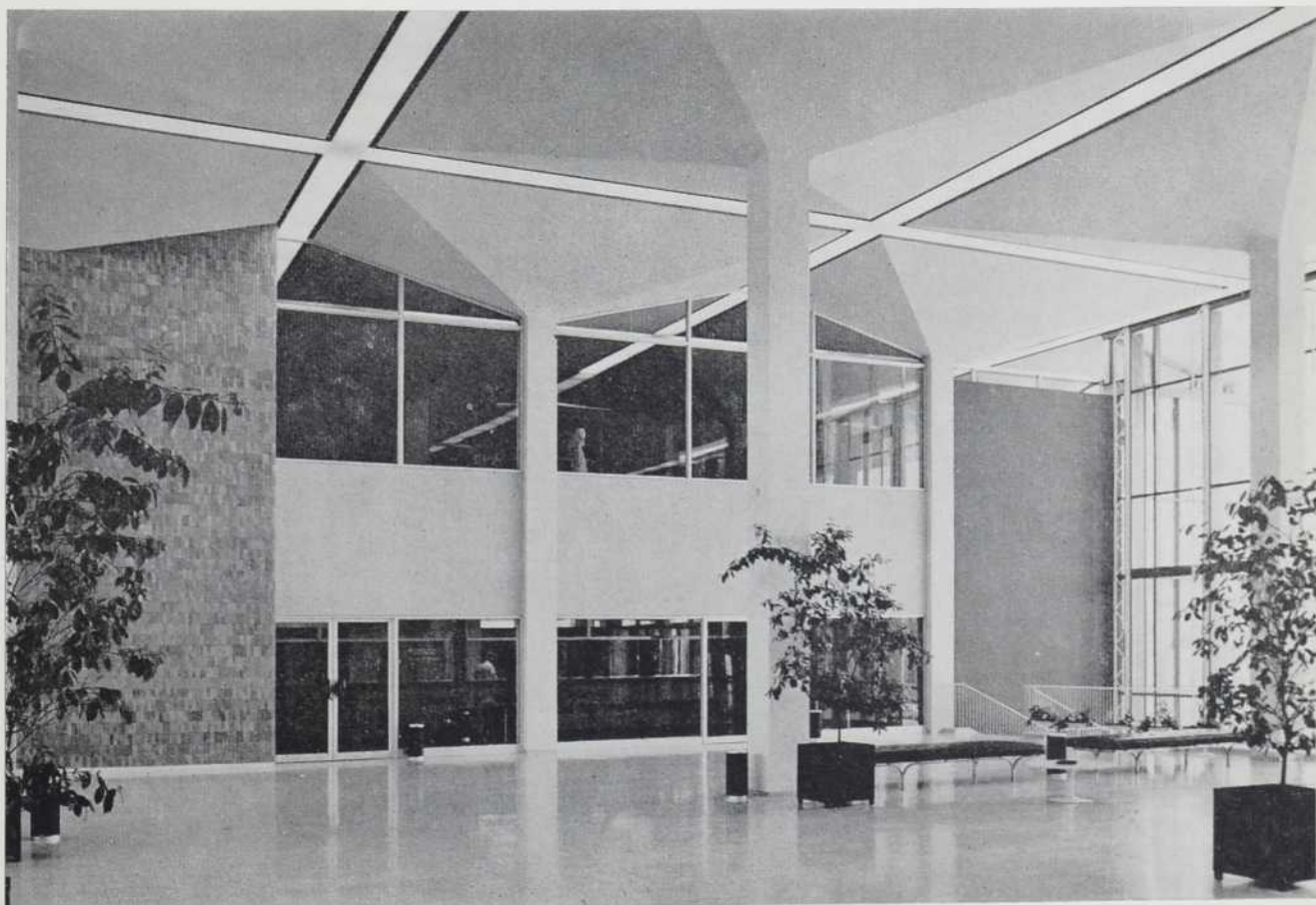
Aspect du hall vers les bureaux d'administration.
