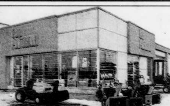
EQUIPEMENT PONTBRIAND 335 St-Valier, Granby 378-0046
