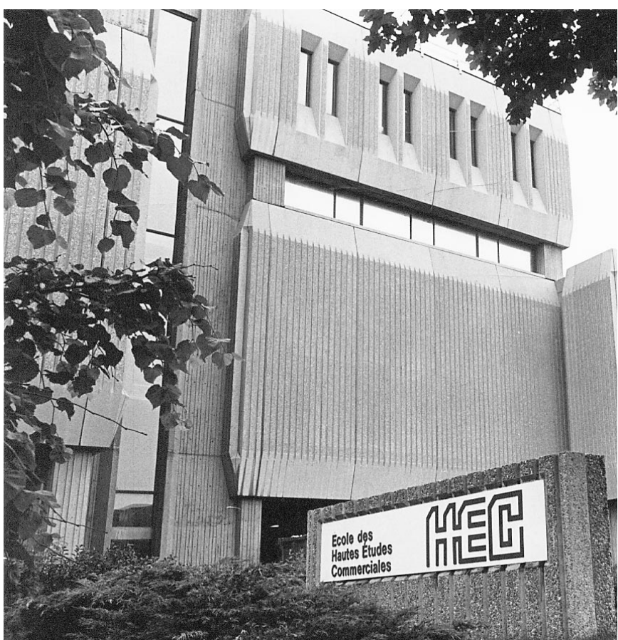
L'INSTITUT de la statistique de l'UNESCO occupera finalement tout un étage de l'ancienne École des hautes études commerciales.
