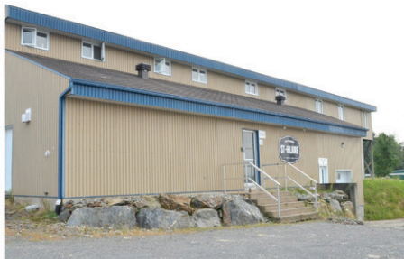
St-Hilaire s'est installé dans les anciens locaux des Fumets Sylvestre.
