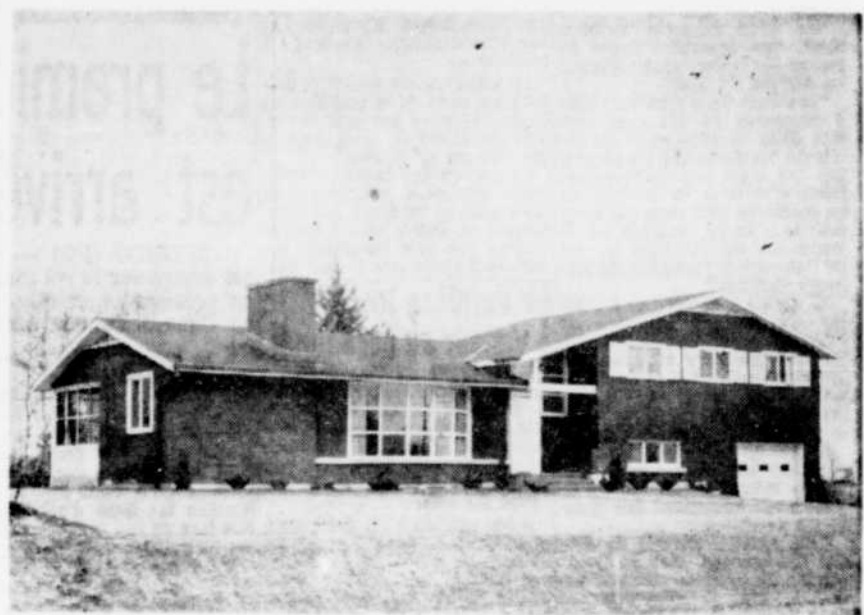
La RESIDENCE du Dr Jacques Beaudry, 2285, d'Youville, la plus récente des quelque 200 maisons construites par l'entrepreneur général J. C. Masson Limitée.
