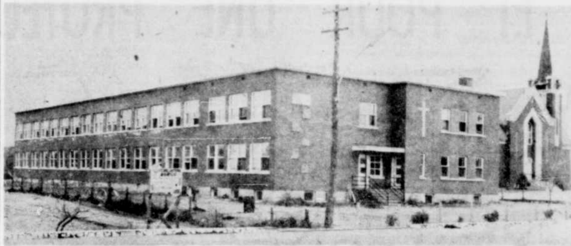
Vue extérieure de l'annexe construite par l'entrepreneur général J. C. Masson de Sherbrooke, d'une superficie de cent vingt-huit pieds par cinquante pieds.
