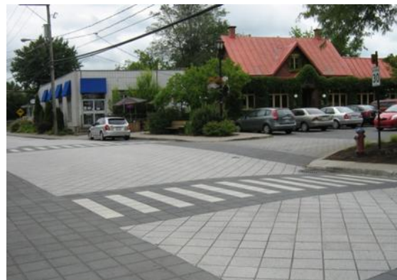
Figure 14 : Intersection surélevée et texturée à Beloeil – photo 1
