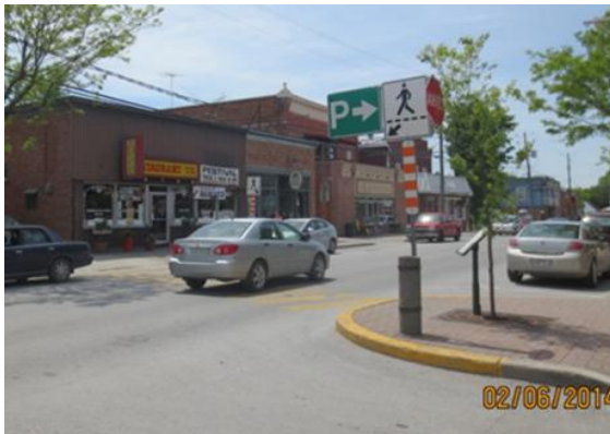
Figure 10 : Exemple d'avancée de trottoir au passage piéton à Bedford
