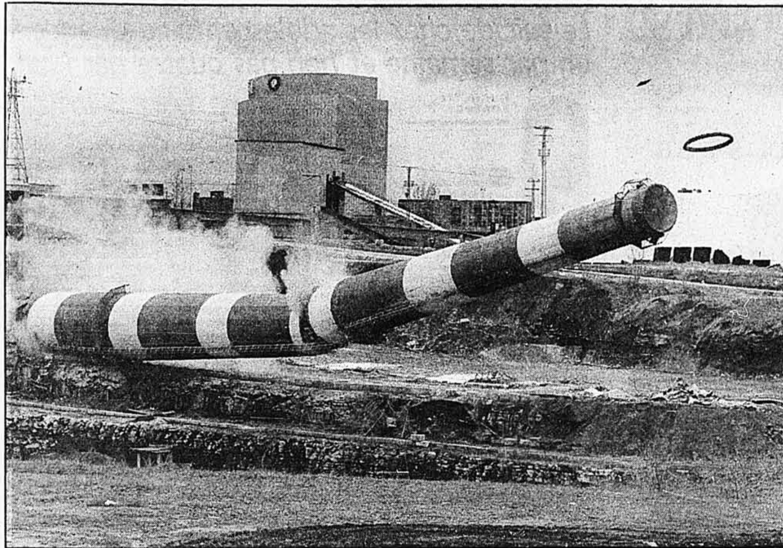
La deuxième cheminée de la carrière Miron, à Montréal, a finalement rendu les armes, hier, peu après 3 h.
