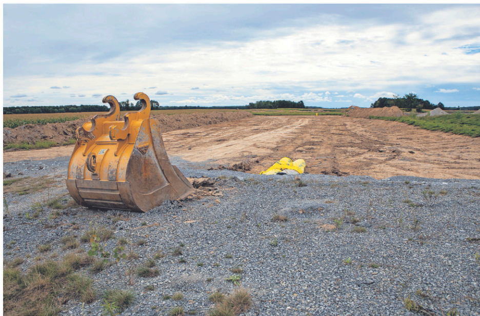
Les travaux de préparation du chantier sont commencés depuis le 14 août.
