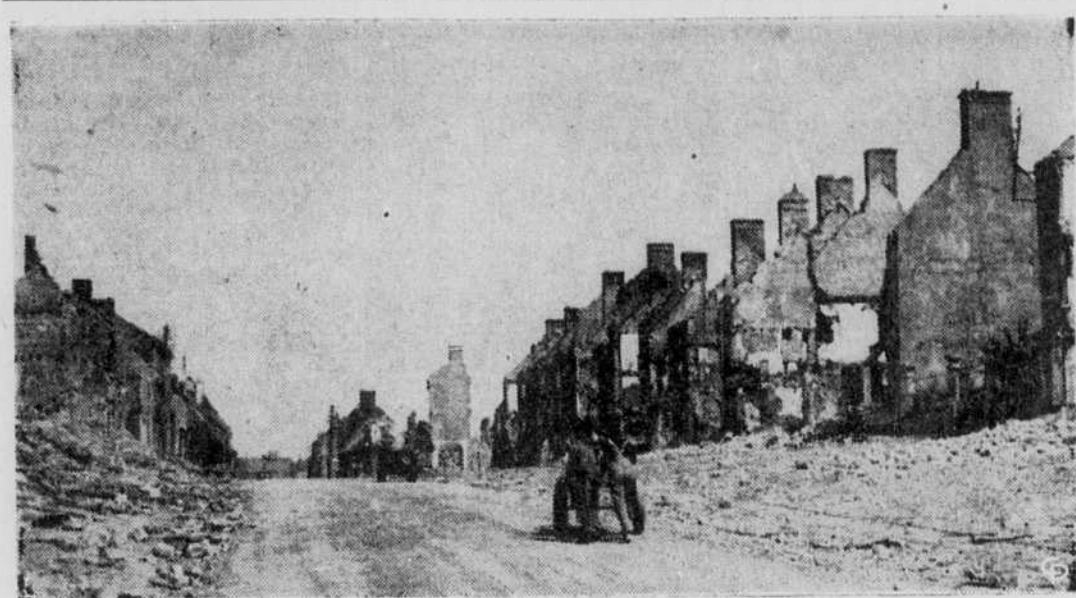
LES VILLES MEURENT : Pas une maison de Pont L'Abbé, en France, n'échappa au souffle destructeur de la guerre. Voici une photo de la route principale de la ville, après que les détachements de nettoyage aient fini leur travail. Les hommes poussant la charrette à bras sont d'anciens résidents de Pont L'Abbé, à la recherche d'un nouveau foyer. (Photo Central Press)
