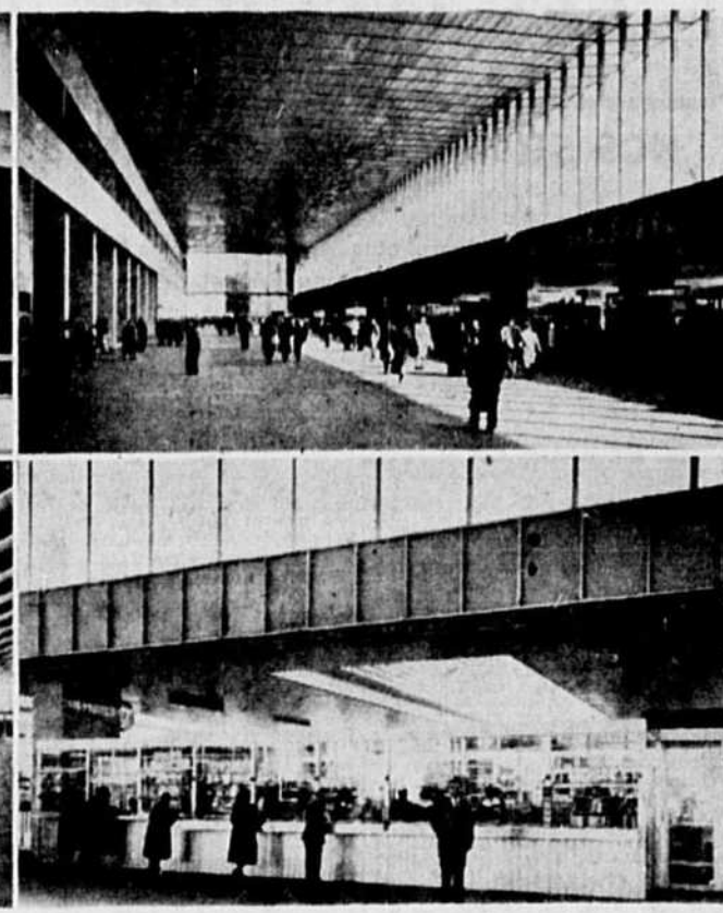
devant les guichets aux billets. A remarquer l'éclairage qui permet une diffusion régulière de la lumière. Les magasins (en bas à droite) sont dégagés, eux aussi et abondamment éclairés. Ils permettent de servir rapidement le voyageur qui se dirige vers le train. Ces magasins sont aussi divisés et agrémentés d'aluminium, métal qui a joué un si grand rôle dans la construction de cette gare ultra moderne.
