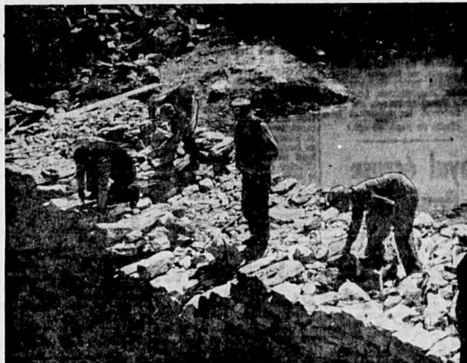
L'IRRIGATION a posé de tout temps de grands problèmes. Mais ces villageois grecs sauront désormais les résoudre, et leurs récoltes en bénéficieront. Ce sont les chômeurs qui s'emploient à ces travaux organisés avec l'aide des représentants du Service de l'assistance technique de l'ONU.
