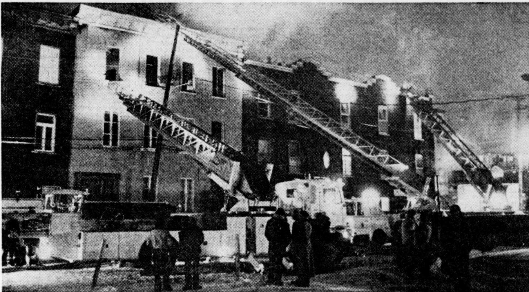
Deux appartements et une épicerie ont subi de lourds dégâts dans le feu de la rue Caron hier soir.
