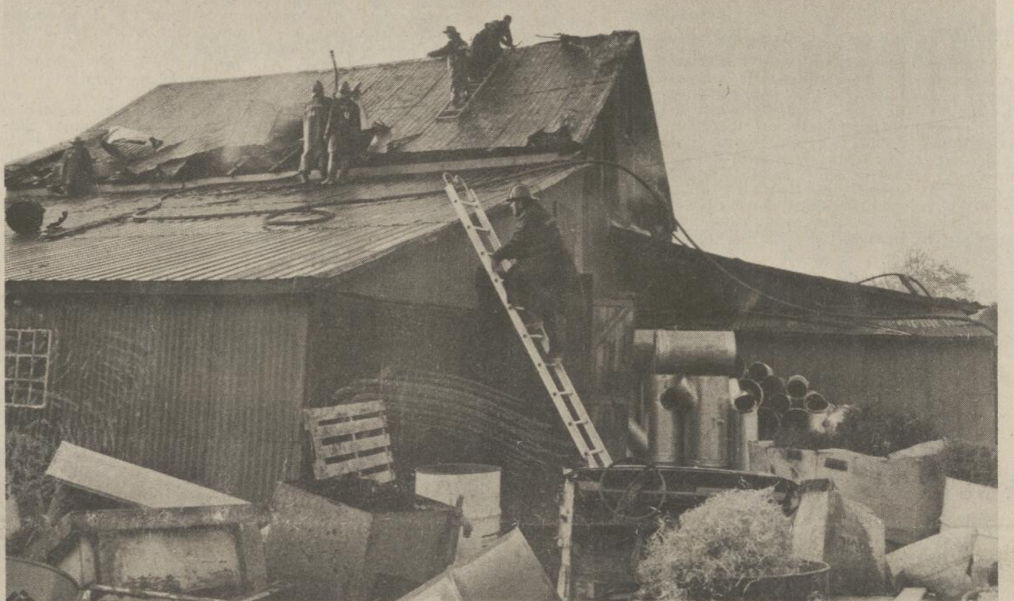
Une vingtaine de sapeurs du Service de lutte contre les incendies de Waterloo ont été dépêchés sur lieux d'un sinistre, dans la soirée d'hier, alors que l'intérieur d'un hangar était ravagé par les flammes. Personne n'a été blessé et les dommages matériels s'élèvent à quelque $5,000.
