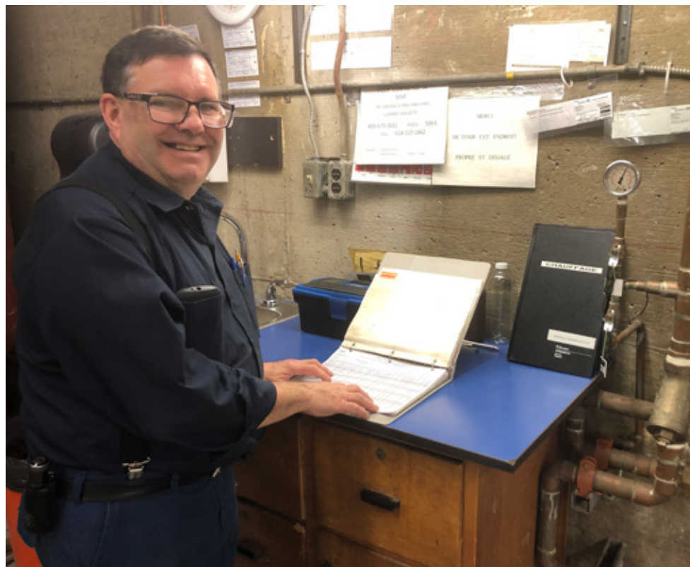
Clément Paquette travaille au sous-sol du Cégep, dans un environnement qui ressemble plutôt à celui d'une usine que d'une institution collégiale.
