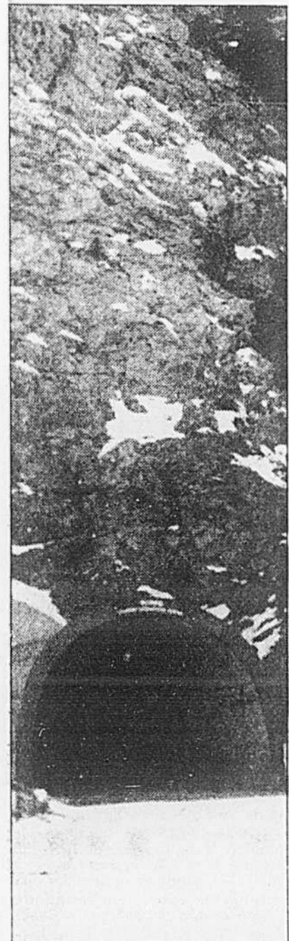
L'entrée du tunnel situé au bas de la montagne de granit par où l'on accède au quartier général de NORAD, après avoir franchi un tiers de mille.
