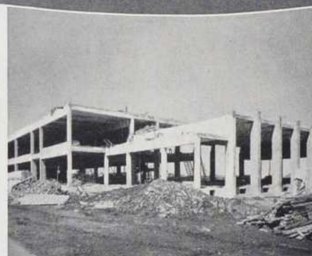
Ecole St-Eugène, Montréal Architecte: Gaston Gagnier Ingénieurs conseils: Lalonde & Valois Entrepreneurs généraux: Quémont Construction Inc.
