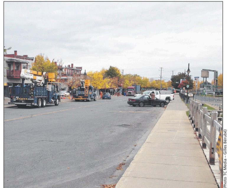
Les travaux nécessitent un réseau temporaire sur la rue du Quai.
