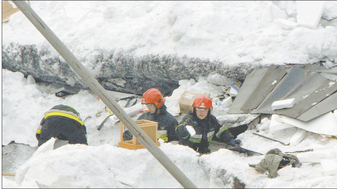
Des hommes fouillaient les décombres après l'effondrement survenu en Pologne, hier, à la recherche de survivants. Environ 1300 secouristes ont été dépêchés sur les lieux.
