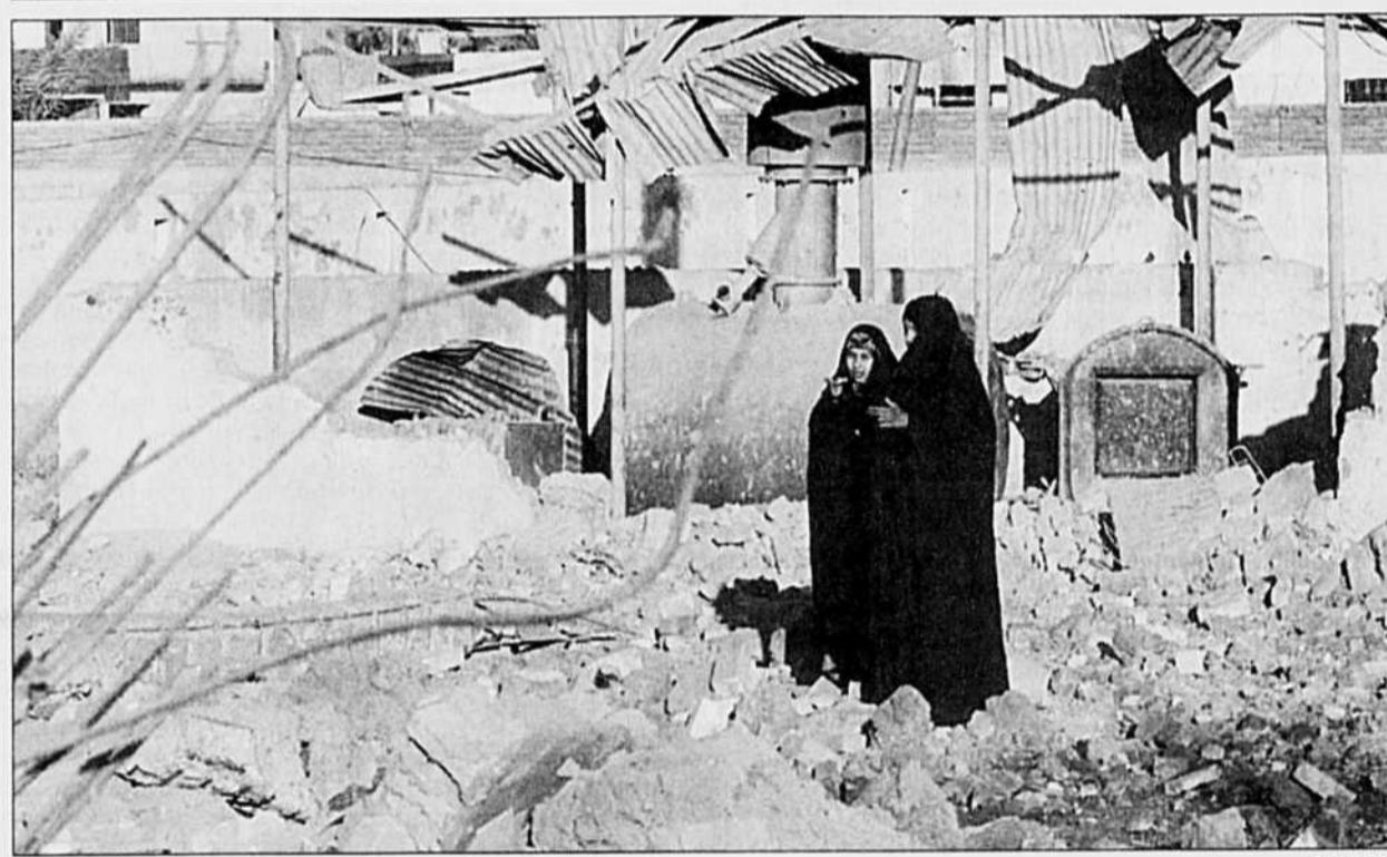
Deux femmes constatent les dégâts causés par des missiles de croisière à un centre de télécommunications et à plusieurs maisons de la banlieue de Basrah, dans le sud de l'Irak.
