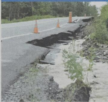
Un peu plus de 40 mm de pluie se sont abattus sur la Beauce dans la nuit du 16 au 17 août, causant quelques dommages.
