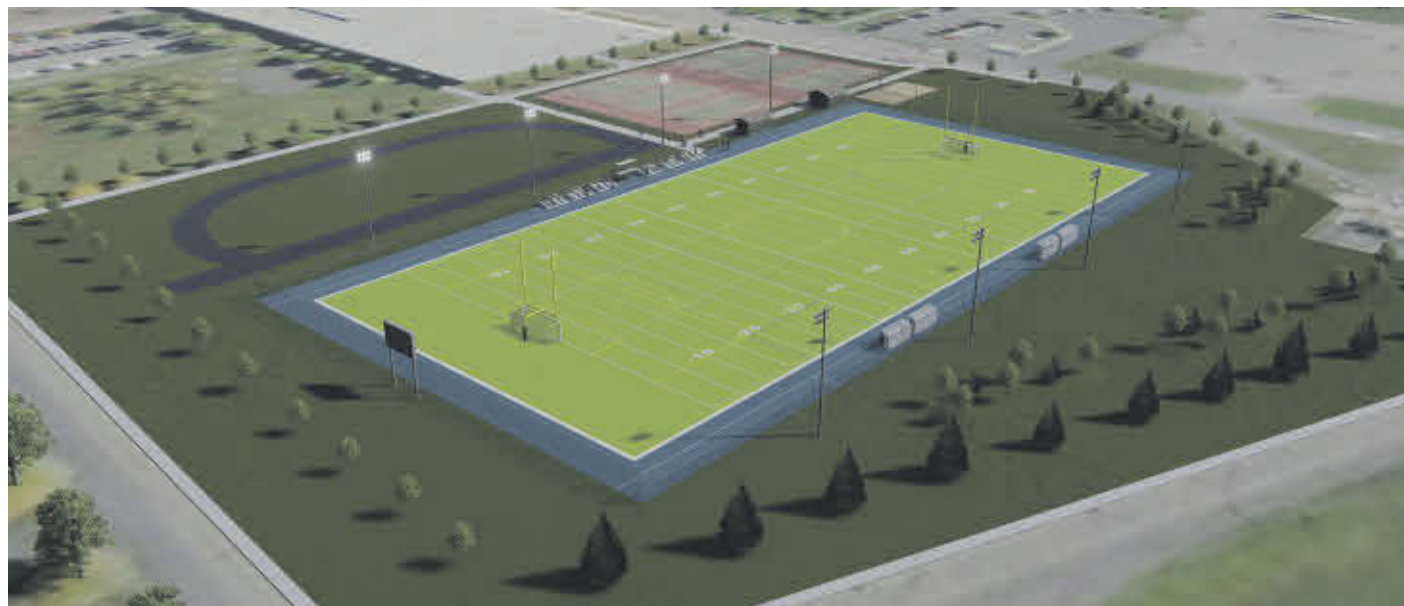
Les travaux pour le terrain synthétique devraient débuter en 2021. Photo gracieuseté
