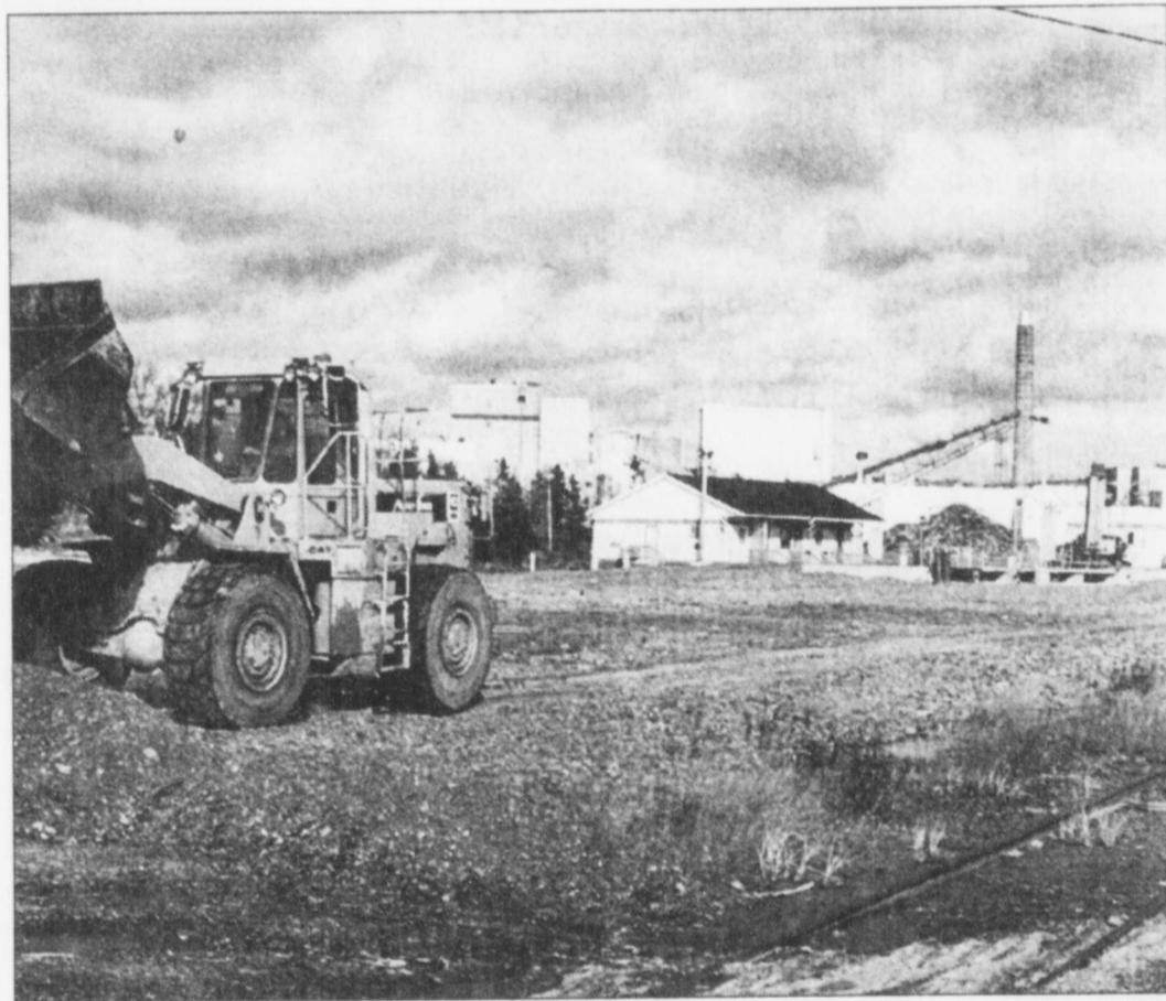
La population de Chandler refuse de baisser les bras face à la fermeture de la mine.
