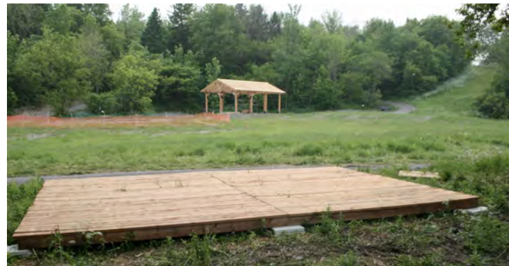
Le plancher en bois de la pergola est construit.
