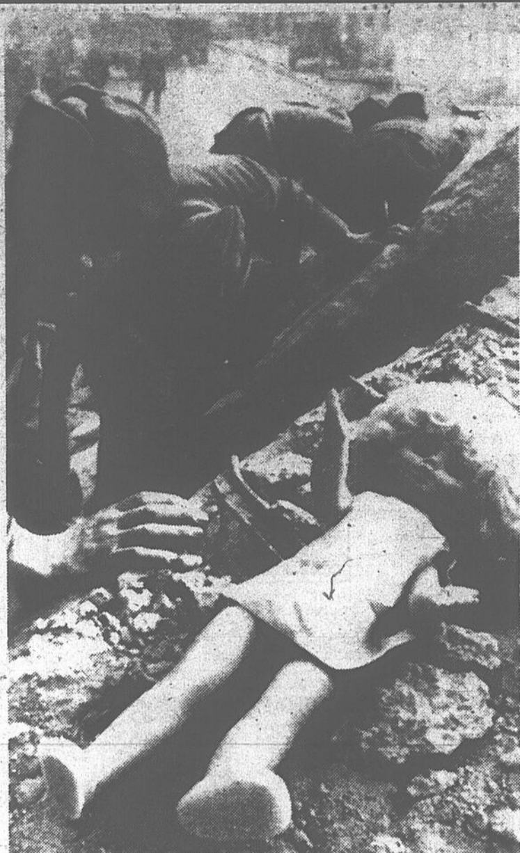
En quête de survivants, les soldats roumains doivent même se servir de leurs mains pour fouiller les débris. La poupée d'une fillette gît sur les ruines.
