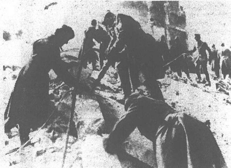
Les soldats doivent forer à travers d'énormes pièces de béton pour pénétrer sous les débris des édifices qui se sont effondrés.
