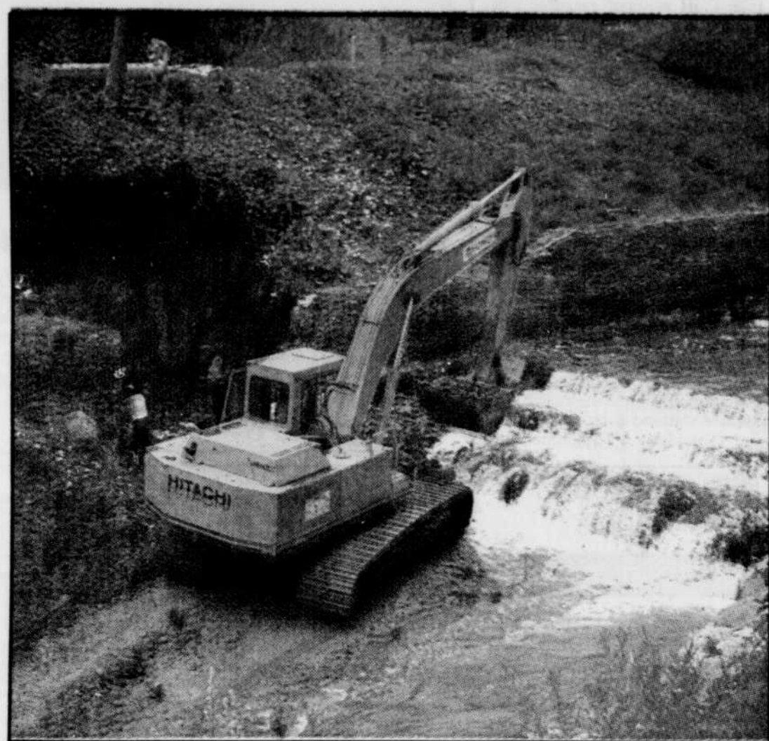
On a dû utiliser une grue mécanique pour consolider les berges de la rivière Beauport.
