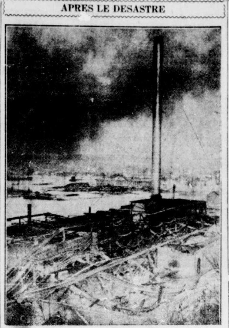
Cette cheminée isolée d'une grande usine de Cincinnati détruite par le feu et les débris qui l'entourent sont autant le témoignage de l'épreuve que vient de connaître, à la suite du débordement de l'Ohio, cette importante cité américaine.
